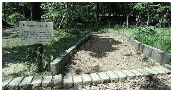
(園路に敷き均したウッドチップ)
